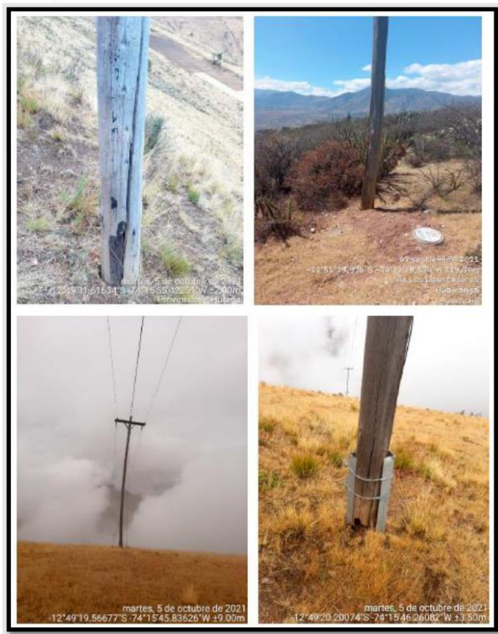
Fig. 2. Postes de madera de media tensión deteriorada
