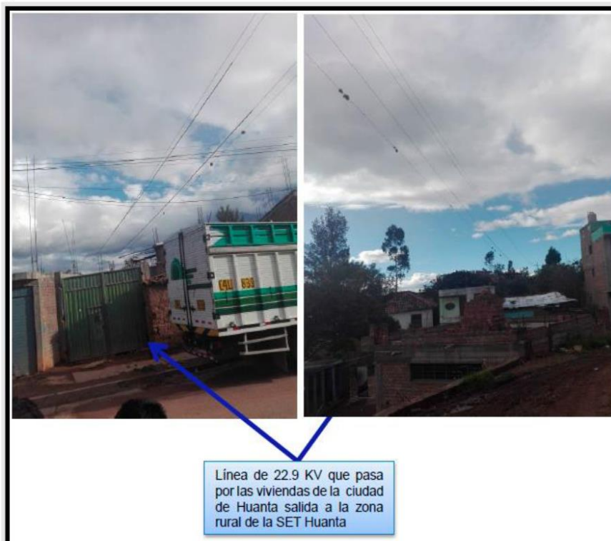
Fig. 3. Redes de media tensión incumplimiento distancias mínimas de seguridad
